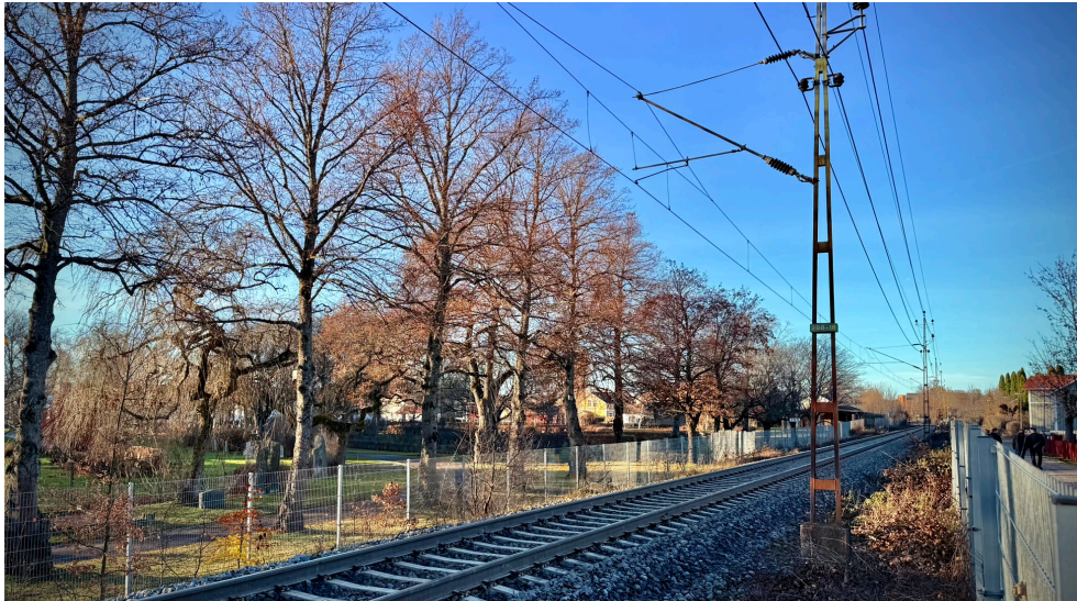
Figur 38. Befintlig järnväg genom Kristinehamn. Omgivande bebyggelse, i detta fall kyrkogården, ligger ofta nära järnvägen.
